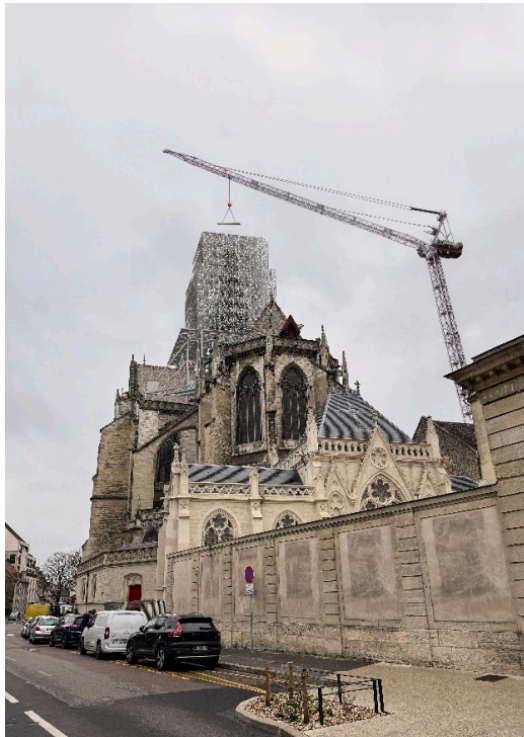
TO2 FLECHE EN COURS DE DEPOSE : ECHAFAUDAGE MI-HAUTEUR
