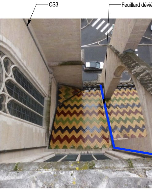
INSERTION CS3 ET DEVIATION FEUILLARD
