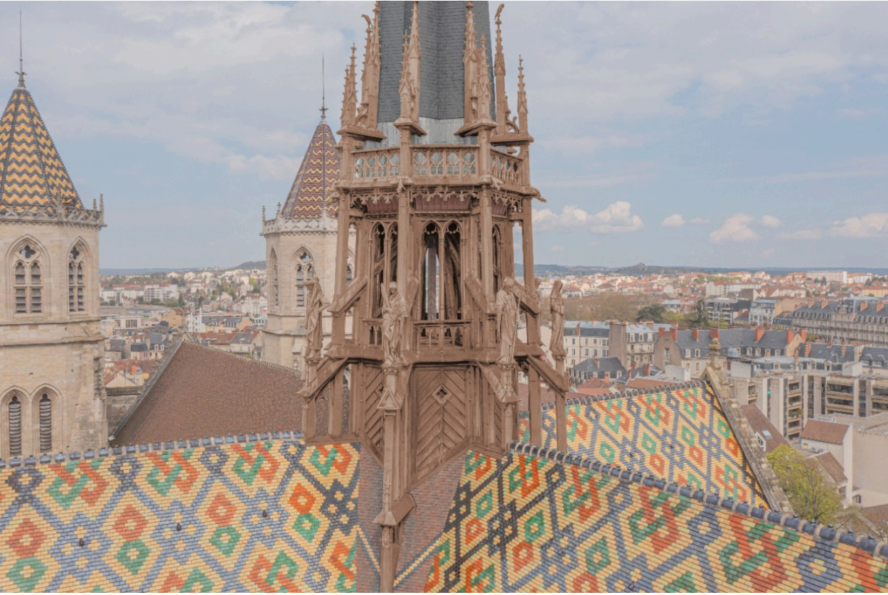
VUE PROJETEE DU FUT DE LA FLECHE APRES LE CHANTIER DE RESTAURATION : CUIVRE DECAPES, PATINES BRUNS
