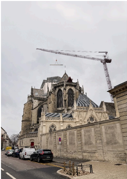
TO2 DEPOSE DE LA SOUCHE : PARAPLUIE OUVERT SUR LA TREMIE DU TABOURET
